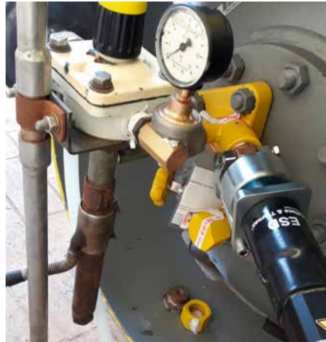
ESD-Sicherheits-Schnellschluss-Antrieb für 500 kg-Chlorfässer
